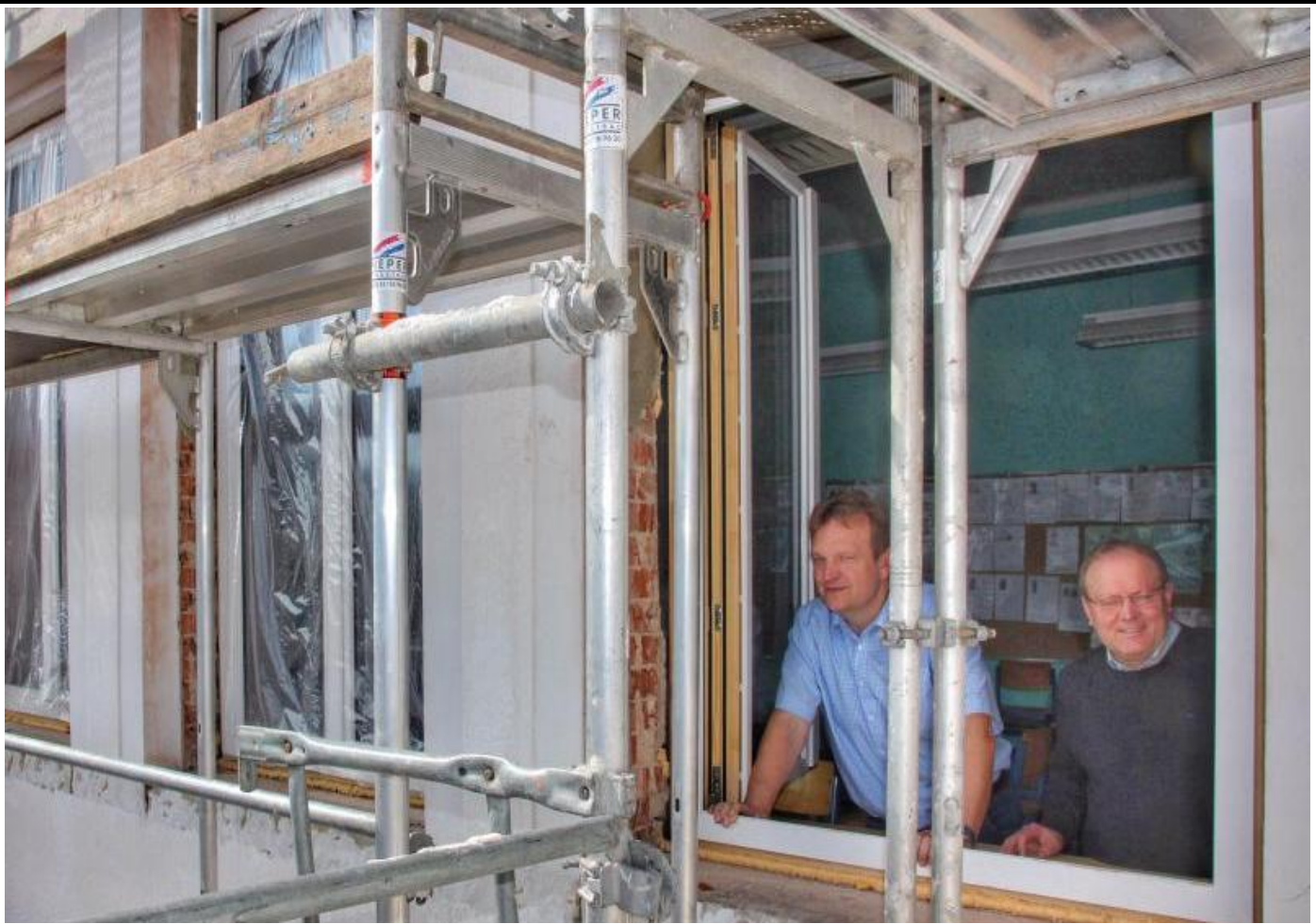
Ein Fenster darf geöffnet werden: Fachbereichsleiter Dieter Hinzmann und Hausmeister Heinrich Wiebe freuen sich, dass die Fenster in den Osterferien eingesetzt wurden. Wegen der Fassadenarbeiten bleiben die meisten verschlossen und verklebt.
