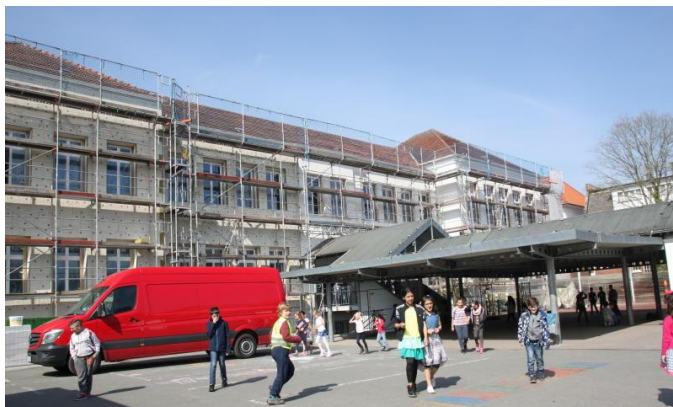
Großbaustelle: Bis zu den Herbstferien dauert die Sanierung der Grundschule Altstadt. Bis dahin bleibt das Gebäude eingerüstet.
